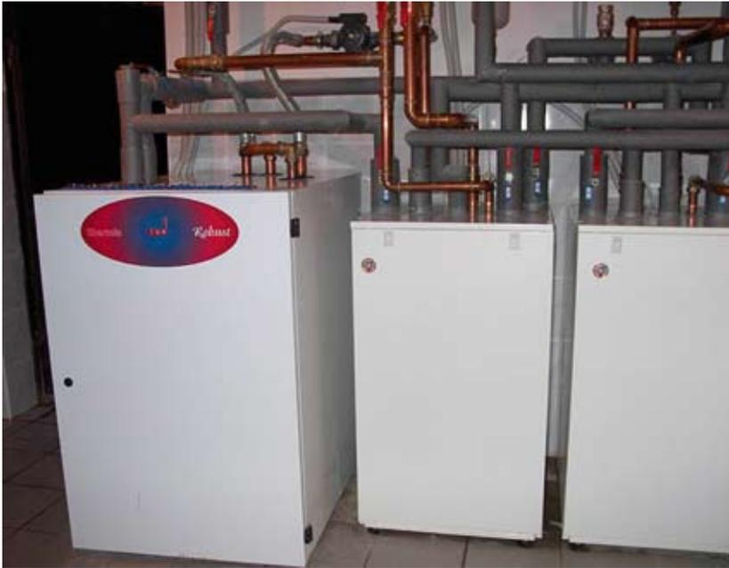
Тепловая насосная установка (ТНУ) ROBUST
